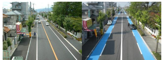
図1 自転車レーン整備前後の状況
