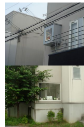
図 24 住宅地 F の印象的な大きな窓
