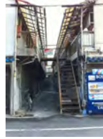
写真4 調査対象地域の外階段
